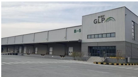
中国・天津一般区倉庫
